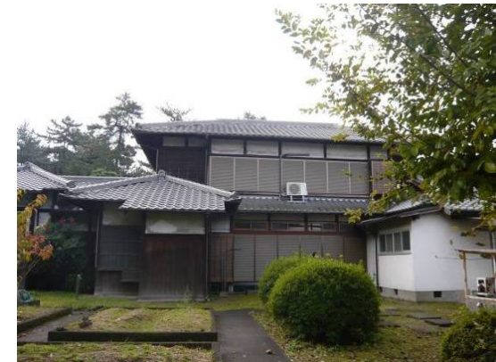
外観 (北側オープンスペースより)
